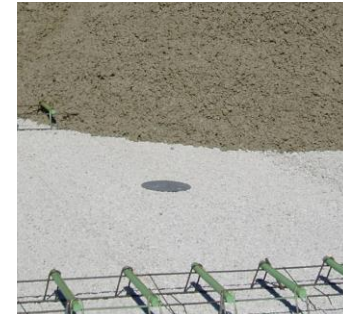
Abb. 11 Stahlrunde, mittig mit Nagel befestigt
