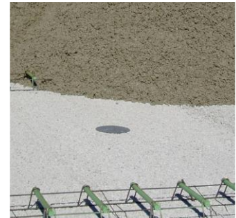
Abb. 10 Stahlronde, mittig mit Nagel befestigt
