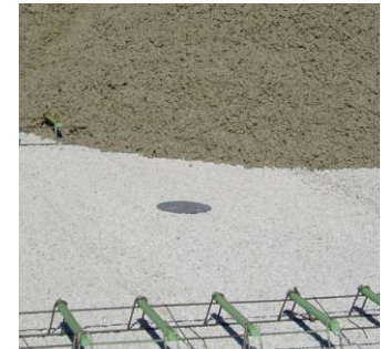
Abb. 10 Stahlrunde, mittig mit Nagel befestigt
